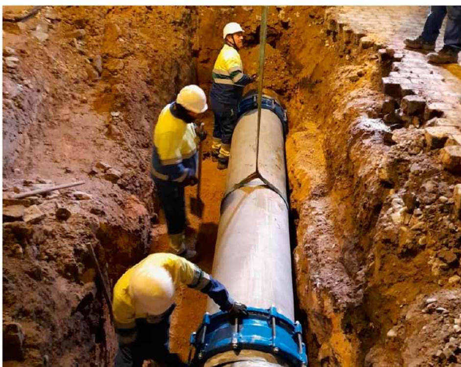
Operarios de Aquajerez, reparando una tubería. - Andalucía Información
