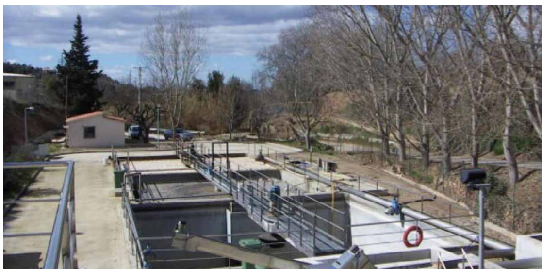
Panorámica de la depuradora de Falset (Tarragona) ACA / Europa Press
