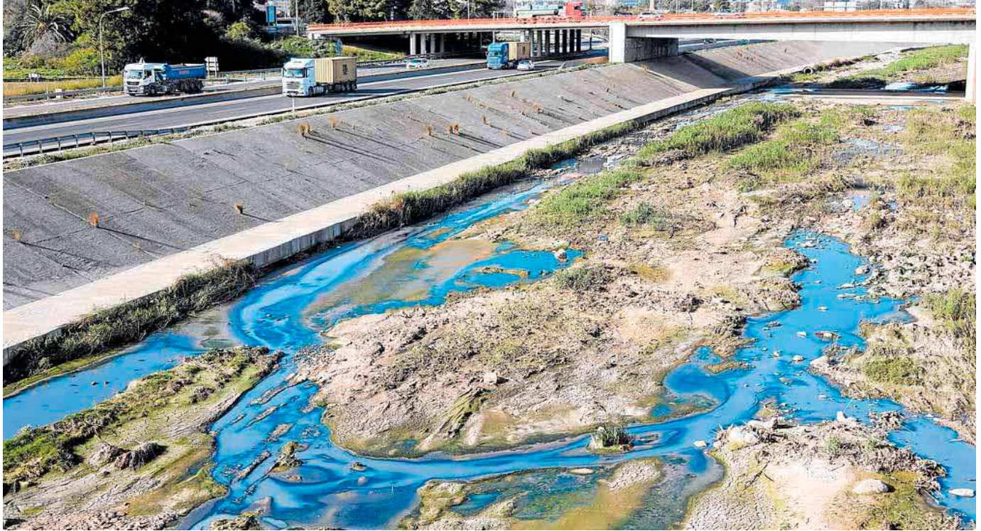
Aguas residuales sin tratar que llegaban al nuevo cauce del río, frente a la pedanía de La Torre, el pasado 10 de enero. JESÚS SIGNES
