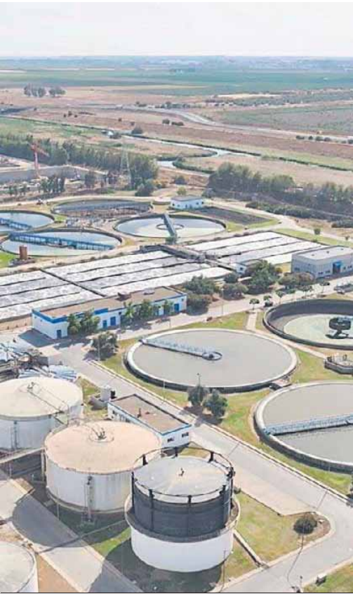
Vista aérea del complejo ambiental Copero de Emasesa.
