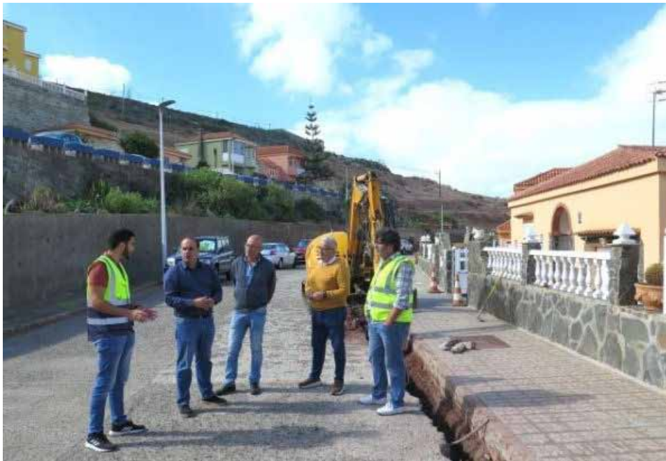
Este proyecto, cuyo importe asciende a 118.022,59 euros, incluye 43 acometidas domiciliarias
